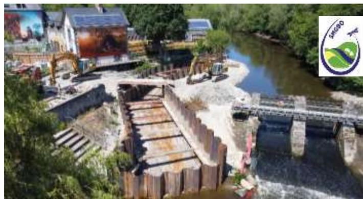
Très prochainement, nous allons voir apparaître les premiers bassins de la passe et ces travaux deviendront plus lisibles. Tout un travail d'embellissement de la passe va s'enclencher avec la mise en place des parements de pierre, le renouvellement des vannes et de la passerelle piétonne, etc...
